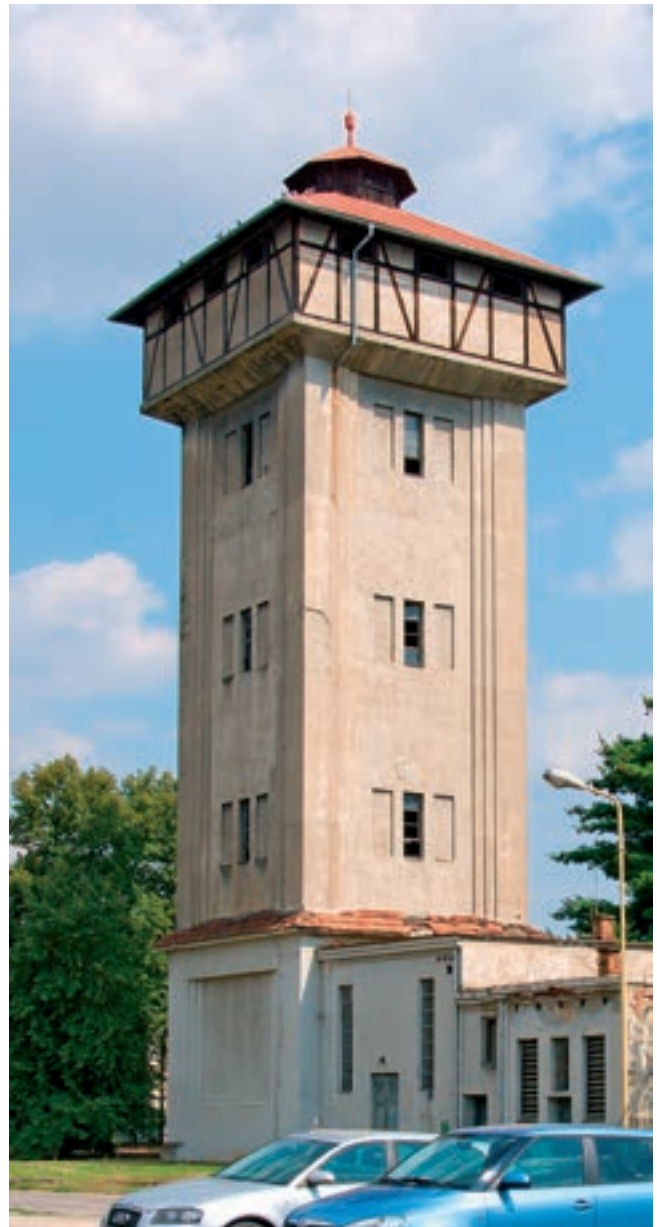
Věžový vodojem nemocnice v Uherském Hradišti. Zdroj: Archiv projektu, 2018
