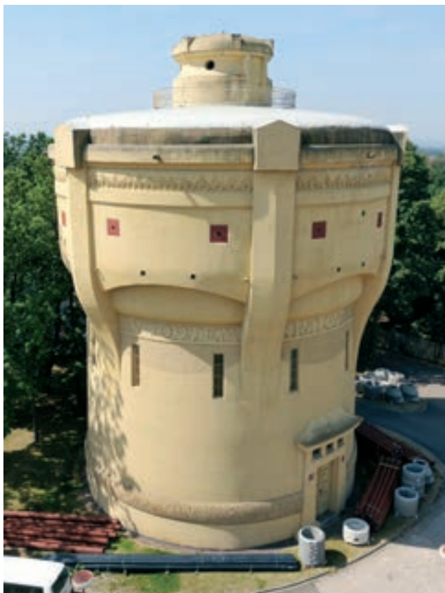
Věžový vodojem z roku 1907 v areálu pardubické nemocnice. Zdroj: Archiv projektu, 2019
