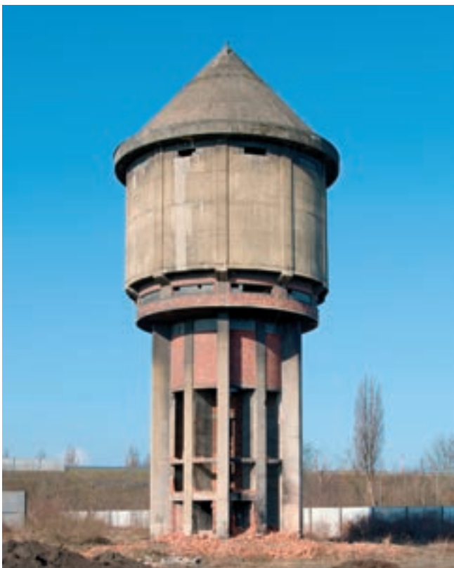
Drážní věžový vodojem v Ostravě-Prívově pár měsíců před demolicí. Zdroj: Archiv projektu, 2019
