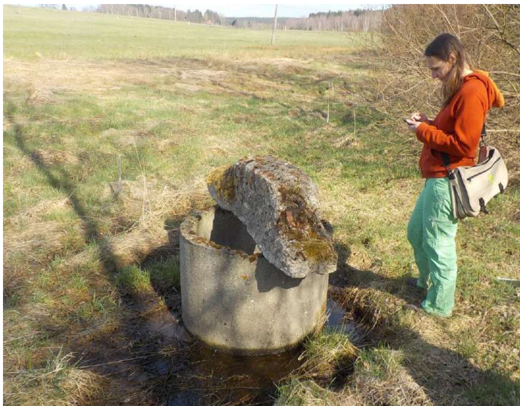
Obrázek 14 – Meliorační skruž v povodí Rokytnice
