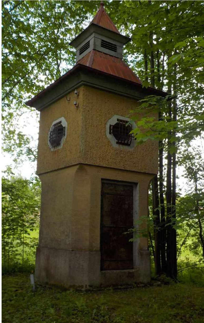
Obrázek 27 – Historický vodojem jímání Štítary v těsné blízkosti státní hranice
