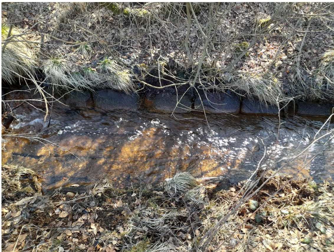
Obrázek 49. Vydlažděné koryto Rokytnice v úseku před křížením se železnici, jižně od obce Hranice
