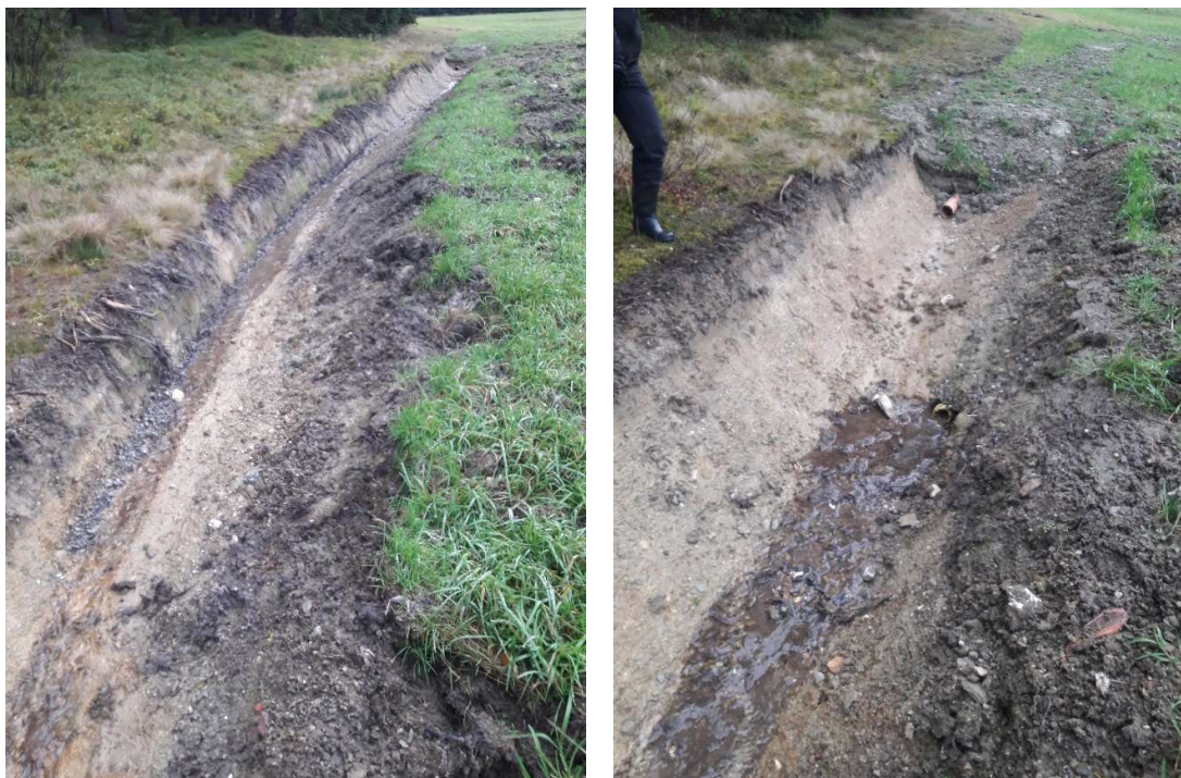
Obrázek 15., Obrázek 16. Nově vybagrované odvodňovací strouhy v místech pramenišť Luz 32 a 33.
