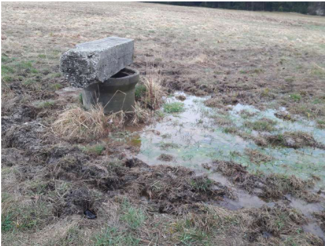
Obrázek 7. Otevřená šachta drenážního systému v povodí Rokytnice na jaře 2022. Drenážní voda vyvěrá v místě poškození trubky a vytváří druhotné prameniště v terénní sníženině, kudy vedla pravděpodobně v minulosti stružka z původního pramene. Horní část drenážního systému je funkční.
