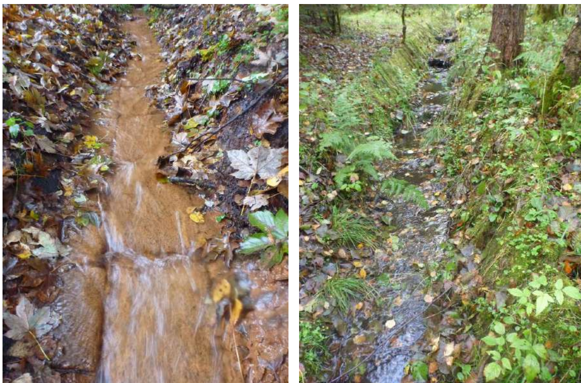
Obrázek 13., Obrázek 14. Narovnané, zahloubené a opevněné pramenné stružky v horní části Újezdského potoka
