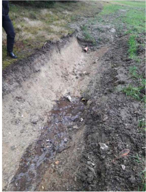
Obrázek 15., Obrázek 16. Nově vybagrované odvodňovací strouhy v místech pramenišť Luz 32 a 33.
