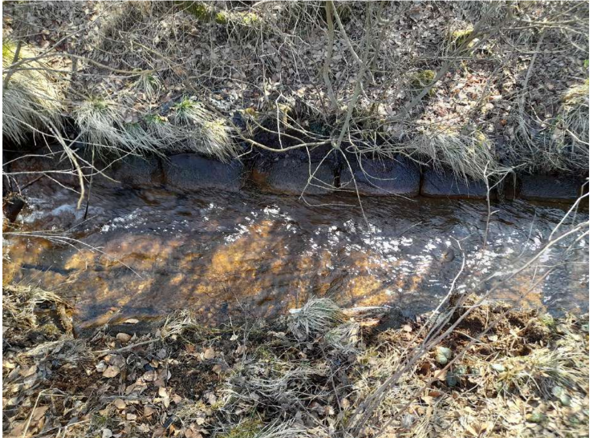
Obrázek 49. Vydlážděné koryto Rokytnice v úseku před křížením se železnicí, jižně od obce Hranice
